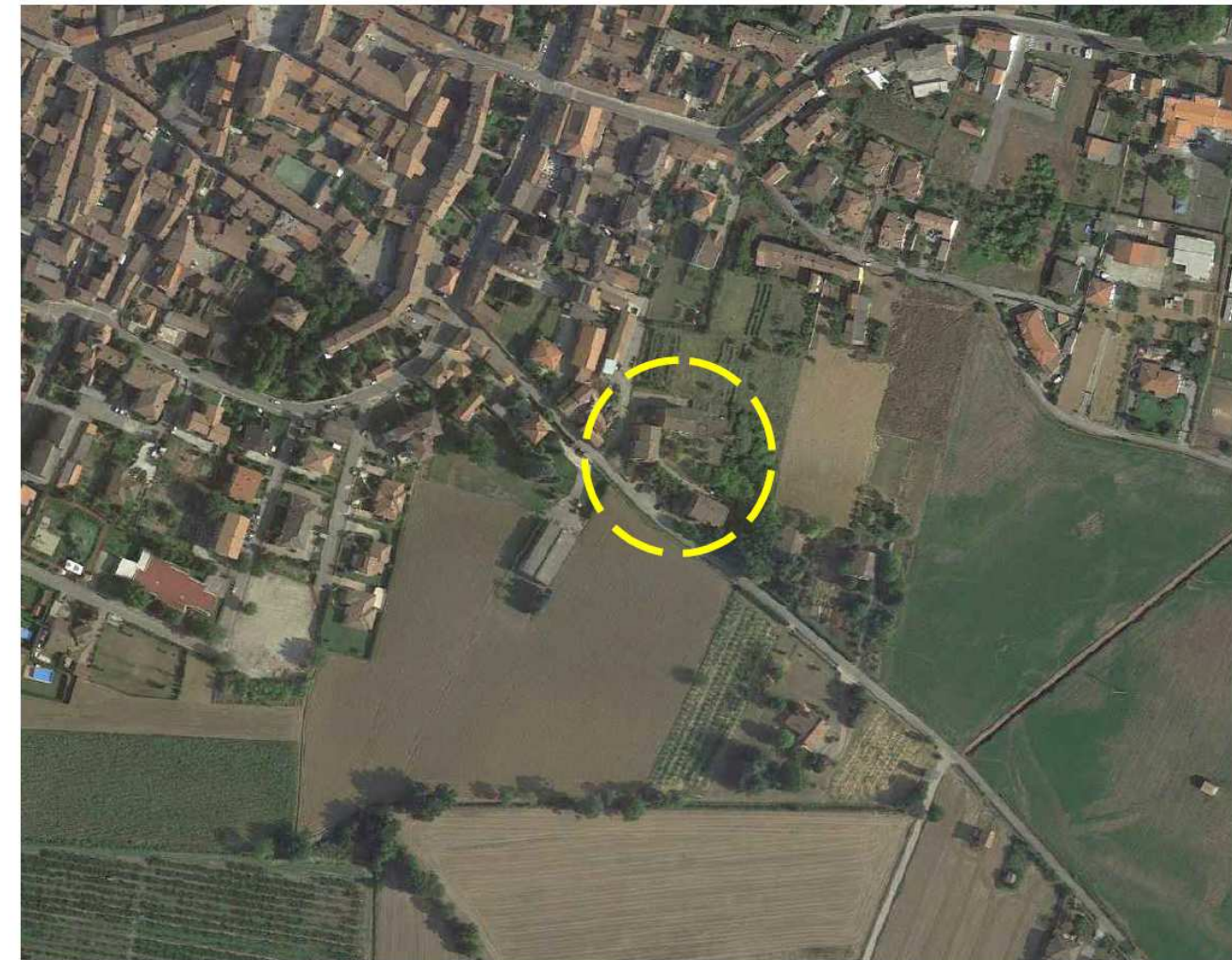
Fig. 4. Ripresa area del sito con localizzazione dell'area oggetto di Variante (fonte Bing maps).
